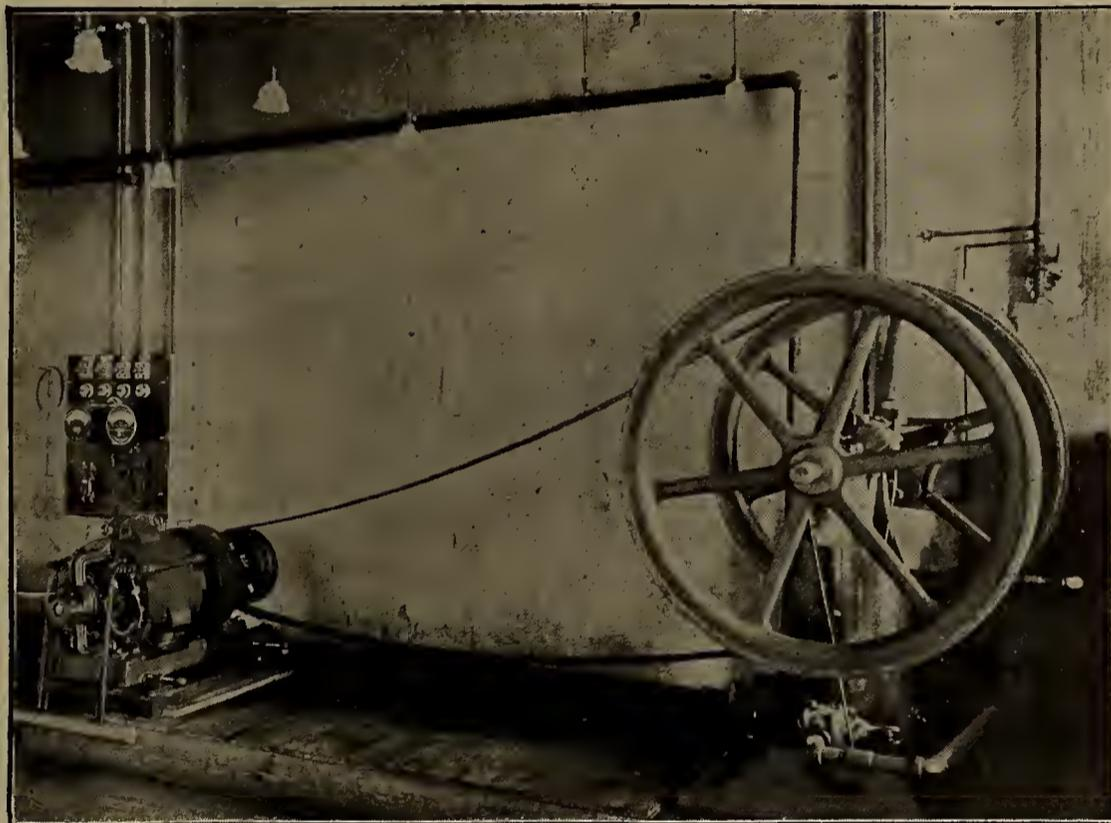
NEW GAS ENGINE FOR ELECTRIC LIGHTING.
