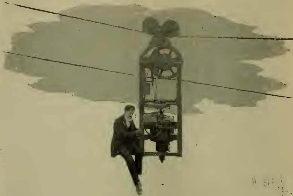
Fig. 6.—Motor used at Tonawanda.
