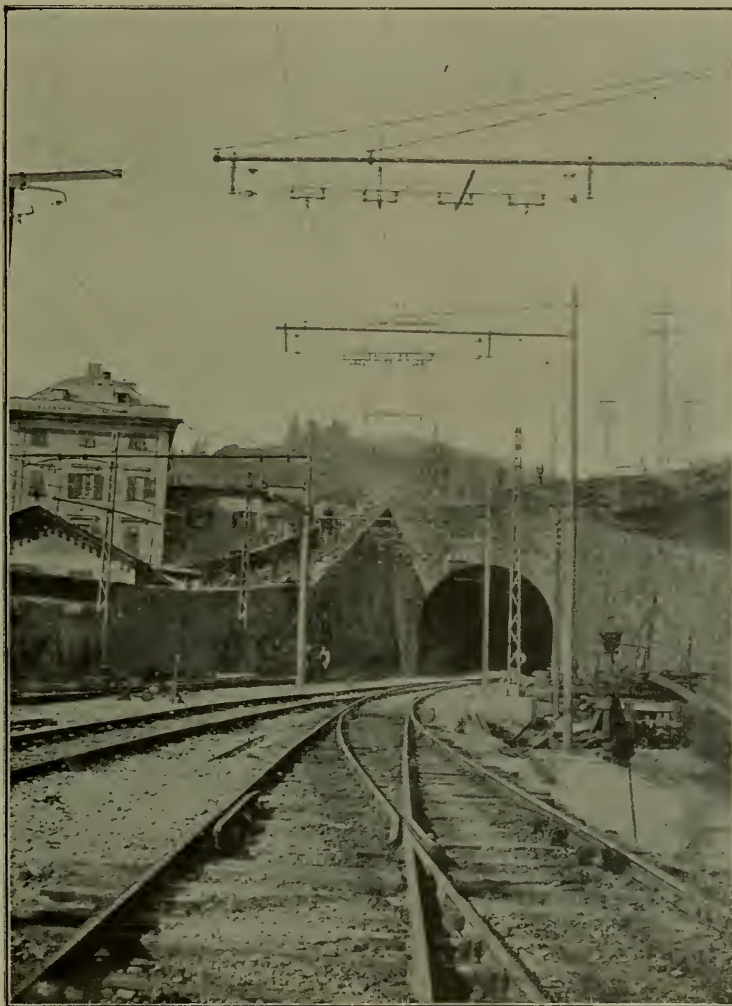
Fig. 153. — Permutation des fils aériens près de la station de Pontedecimo.
