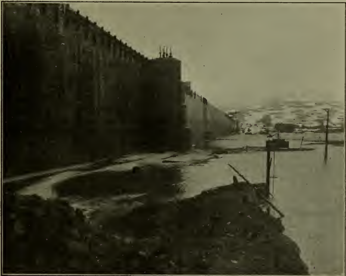
Fig. 203. — Barrage de l'installation électrique de Kinloch-Leven.
