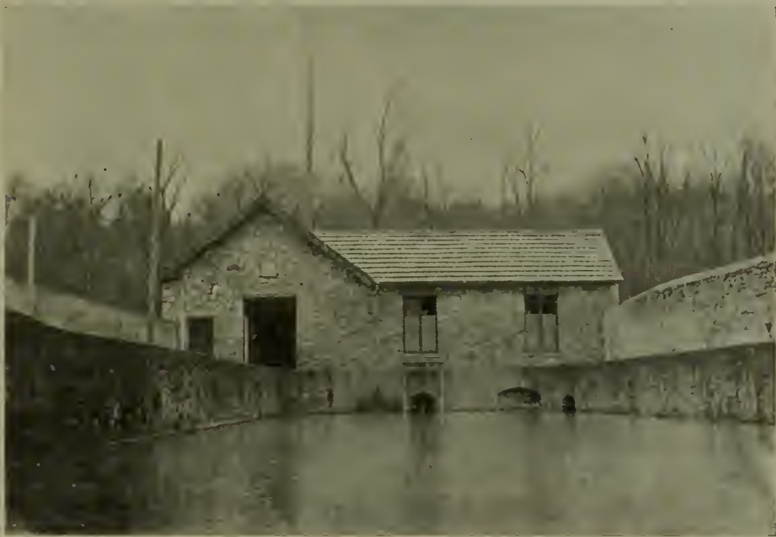
Fig. 241. — Le Ru de Gally à Villepreux. Bief de l'usine hydraulico-électrique municipale.
