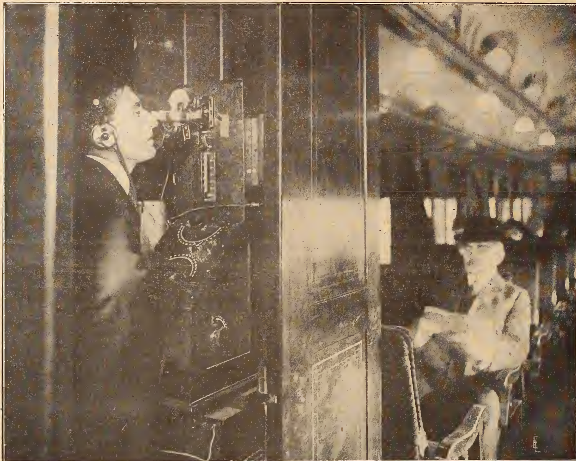
Fig. 4. Poste d'intercommunication par téléphonie sans fil dans un train américain.
