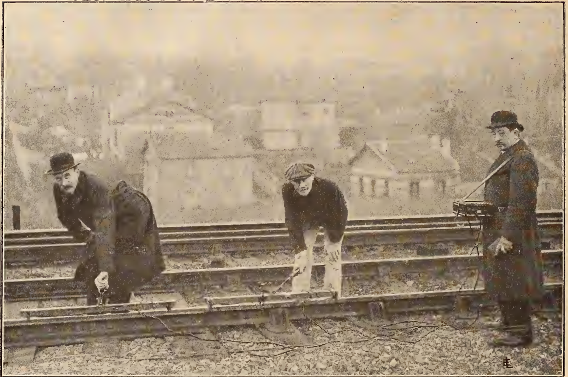
Fig. 18. — Vérification d'un joint de rails.
