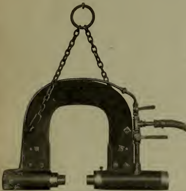
FIG. 3.—NO. 2 YOKE RIVETER 16 IN. YOKE.
