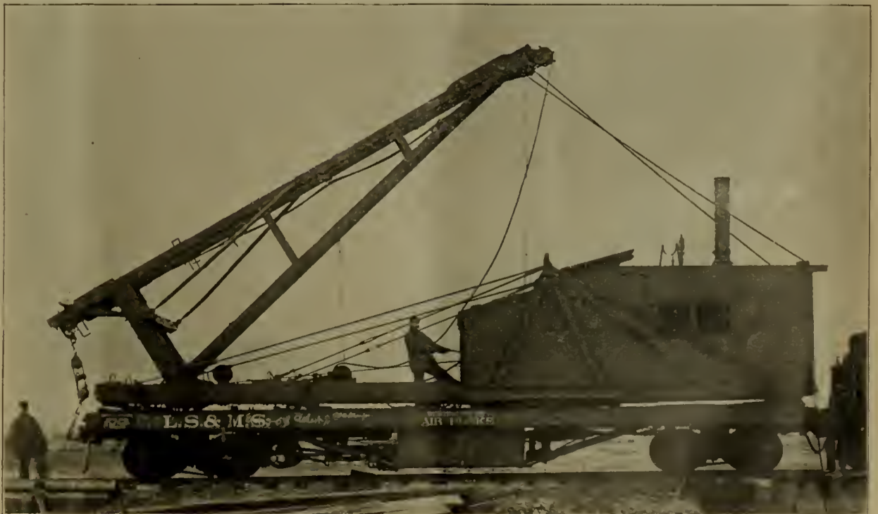
FIG. 2.—PILE DRIVER—L. S. & M. S. RY.—HOISTING THE LEADS.
