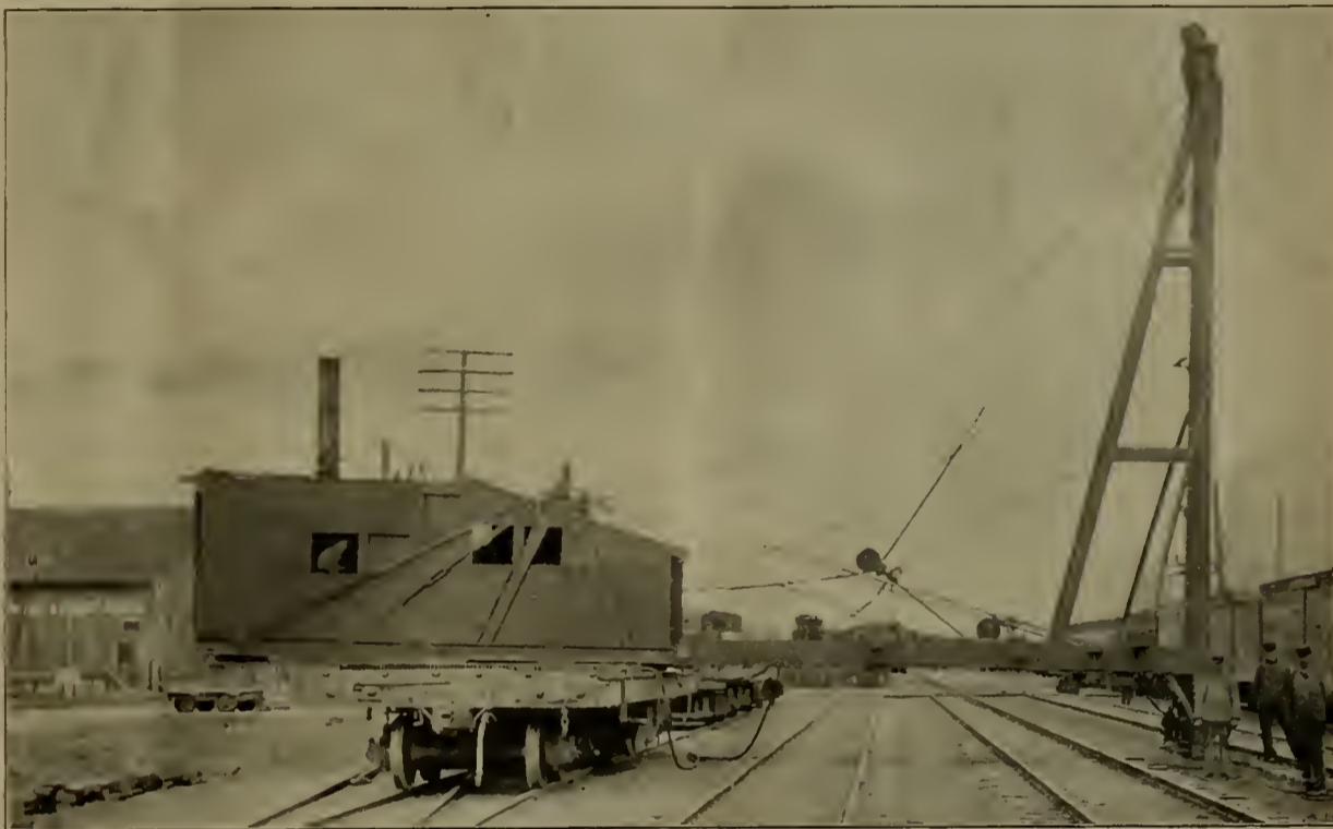
FIG. 5.—PILE DRIVER—L. S. & M. S. RY.—WITH 30-FT. SIDE REACH.
