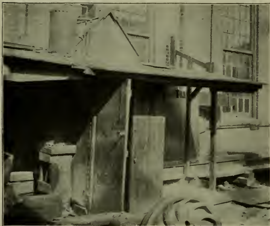
SHEET CLEANING SAND BLAST, P. & L. E. R. R.
